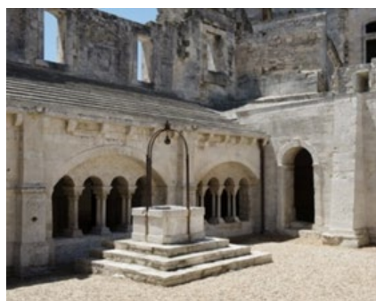
Abbaye de Montmajour, cloître, puits © Colombe Clier - CMN
